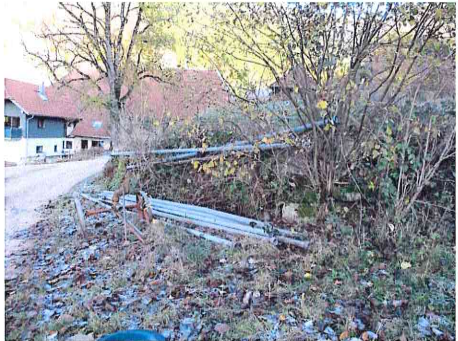
Abbildung 5: Freilegen und Neubau der Mauer im Bereich 2
