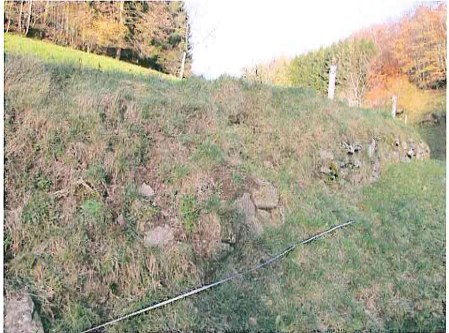
Abbildung 10: Teil der Mauer der aufgesetzt wird
