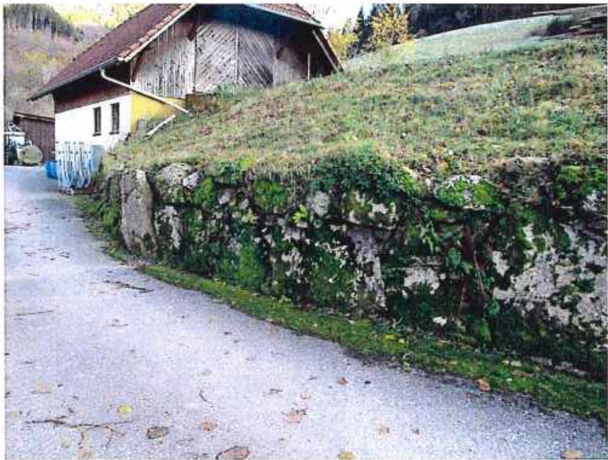
Abbildung 4: Mauerabschnitt nahe Gebäude
