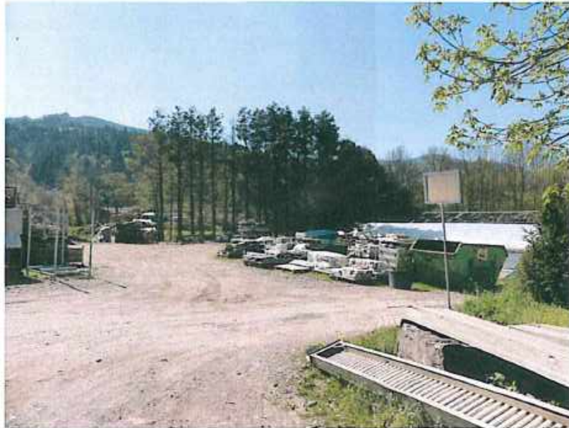
Abb. 8: Südlicher Bereich Lager- und Wendeflächen sowie einem hochgewachsenen Thuja-Bestand.
