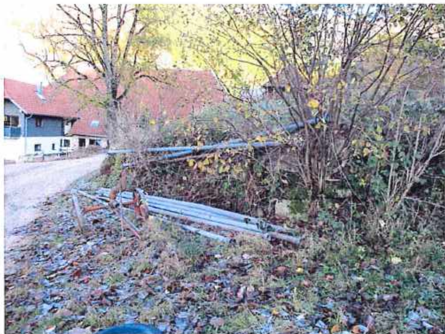
Abbildung 5: Freilegen und Neubau der Mauer im Bereich 2
