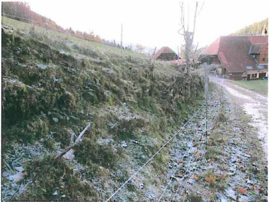
Abbildung 2: Übergang von besserem (Abschnitt 2) zu schlechtem Zustand (Abschnitt 3)
