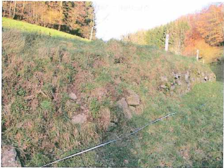
Abbildung 10: Teil der Mauer der aufgesetzt wird
