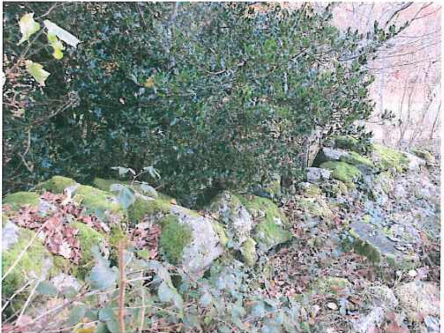
Abbildung 7: Noch erkennbarer Teil der Mauer, Blick Richtung SW, zu entfernde Gehölze
