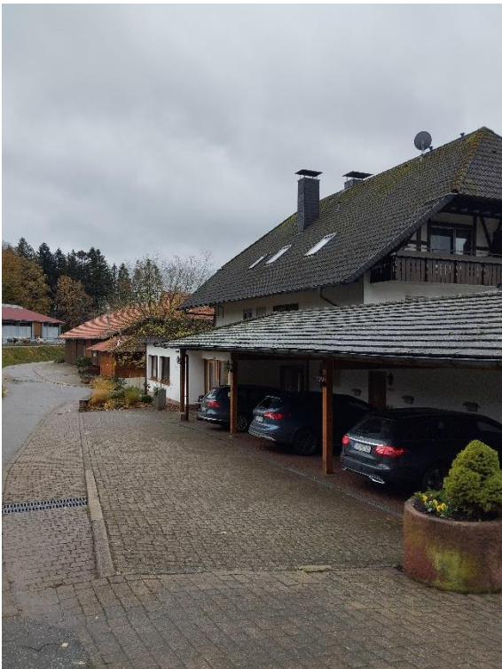
Foto 3: Blick auf ein Bestandsgebäude
